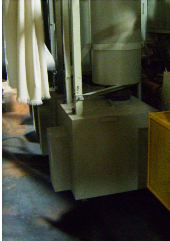
Rys.4 Widok pojedynczego wentylatora po zabudowie obudowy dźwiękochłonna-izolacyjnej
