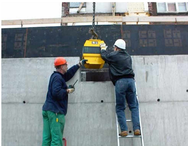
Instalacja wibroizolatorów
